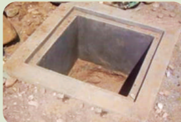
Colocación de losa de concreto
