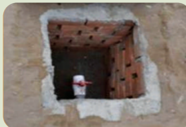
Colocación del Biodigestor
