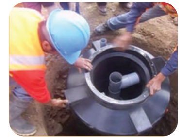
Colocación del Biodigestor
